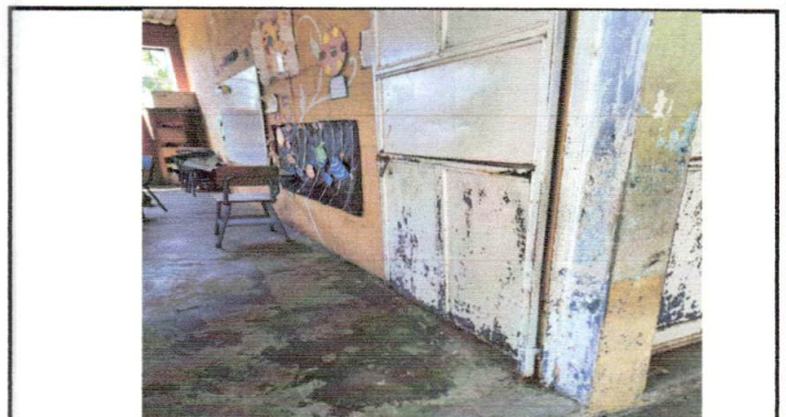
Foto 4: SUSTITUCION DE PISO DE CEMENTO POR PISO CERAMICO
