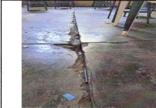
Foto 1: SUSTITUCION DE PISO DE CEMENTO POR PISO CERAMICO
