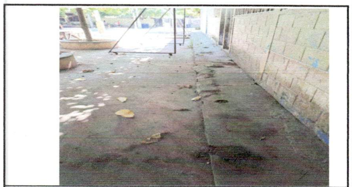
Foto 6: SUSTITUCION DE PISO DE CEMENTO POR PISO CERAMICO
