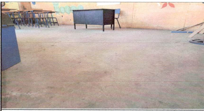
Foto 5: SUSTITUCION DE PISO DE CEMENTO POR PISO CERAMICO
