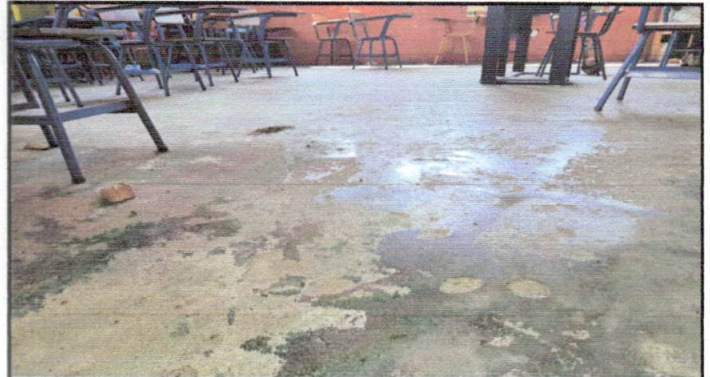
Foto 2: SUSTITUCION DE PISO DE CEMENTO POR PISO CERAMICO
